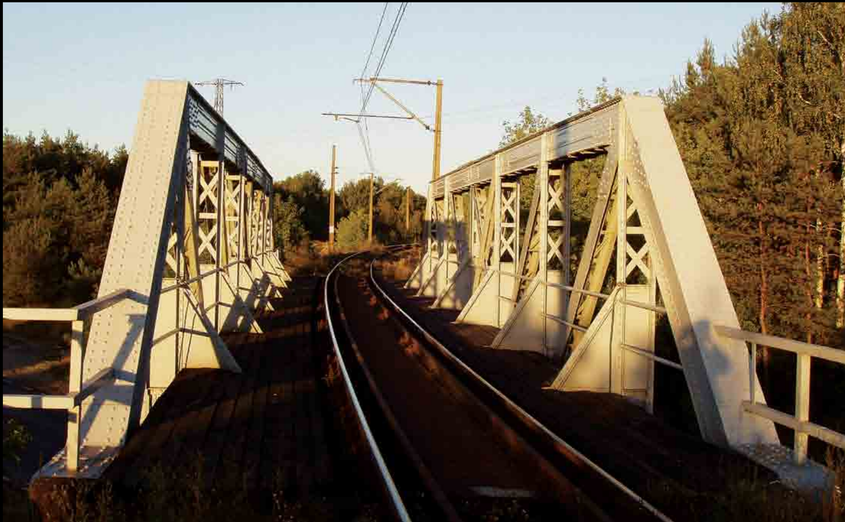
Wiadukt kolejowy linii nr 10 w Wieliszewie, autor: Czesław Prędoła
