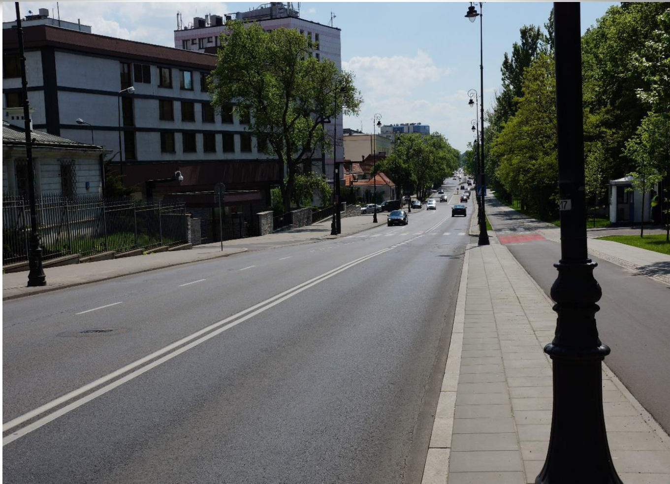
Przykład oświetlenia ulicznego dwustronnego, naprzemiennego
