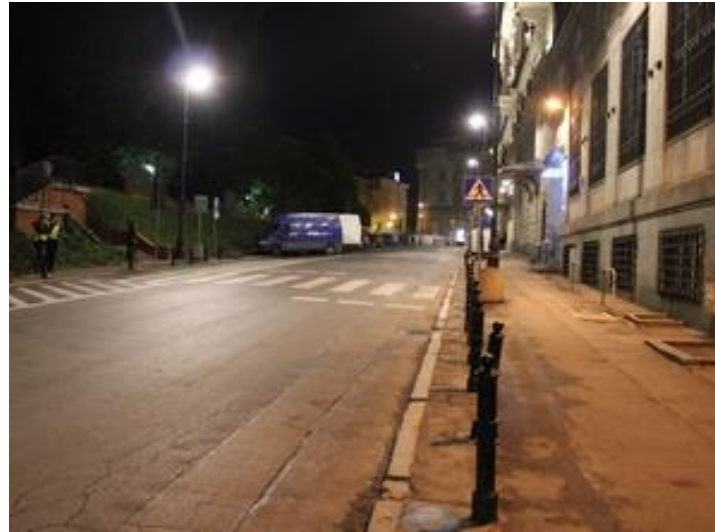
Brak klasy oświetleniowej, wysokie parametry natężenia oświetlenia i niespełniony warunek równomierności
