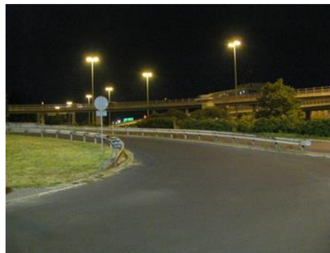
Wjazd na pętlę
