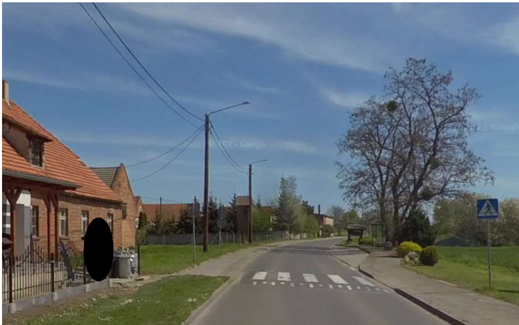
droga powiatowa nr 1274D w miejscowości Węglewo
